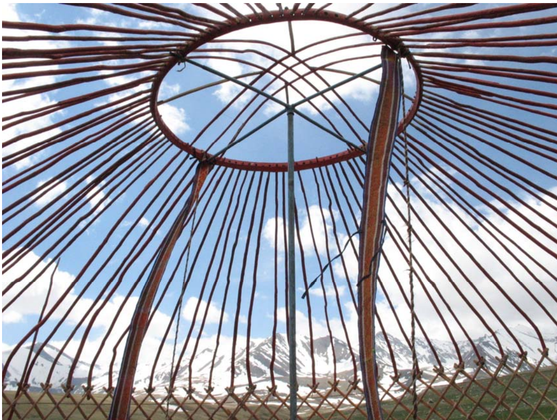
Dachkranz und Dachstäbe einer kasachischen Jurte in der Westmongolei Foto und Copyright: Uta Schilling [Bild-Titel: Uta Schilling:Mongolei 15]
