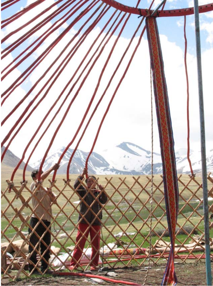
Beim Aufbau einer kasachischen Jurte im Sommerlager (Westmongolei) Foto und Copyright: Uta Schilling [Bild-Titel: Uta_Schilling_Mongolei 16]
